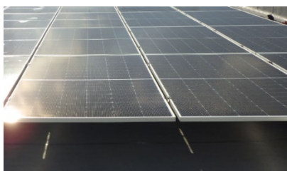
同ホームの太陽光パネル(写真左/搭載容量 48.72kW)と蓄電システム(写真右/手前 家庭用蓄電池:21.6kWh、奥 産業用蓄電池:48.6kWh)
