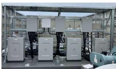
同ホームの太陽光パネル(写真左/搭載容量 48.72kW)と蓄電システム(写真右/手前 家庭用蓄電池:21.6kWh、奥 産業用蓄電池:48.6kWh)
