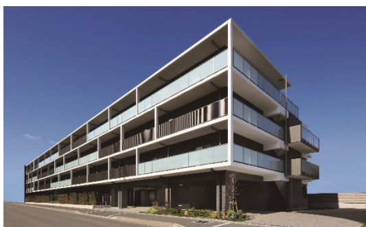
屋上に太陽光パネル・蓄電システムを設置した「リハビリホームグランダ高槻」(2024年12月開設/大阪府高槻市)
